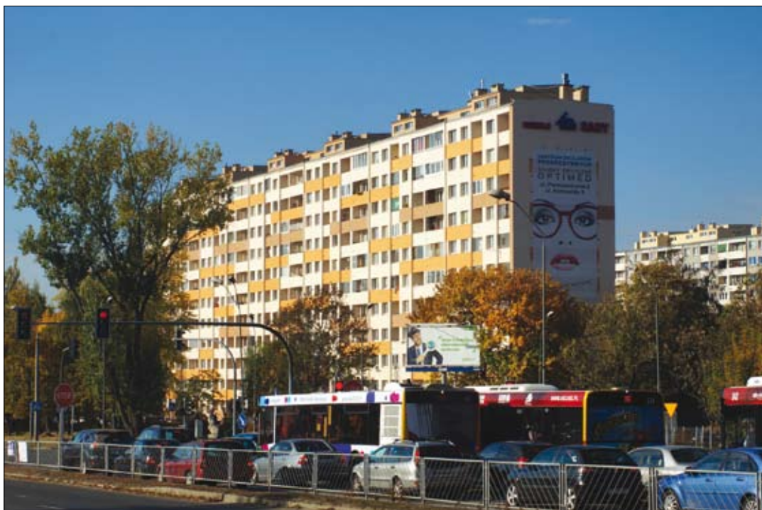
Nowa elewacja wieżowca przy ul. Nowowiejskiej 24
