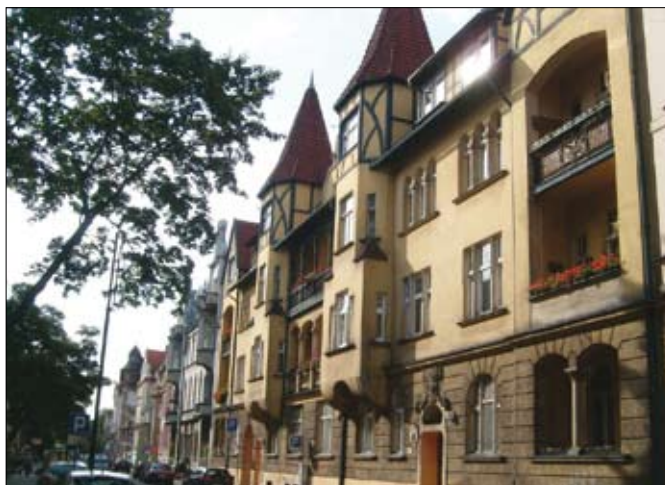
Bydgoska Spółdzielnia Mieszkaniowa. Jeden z pierwszych budynków spółdzielczych, kamienica przy ul. Cieszkowskiego 13
