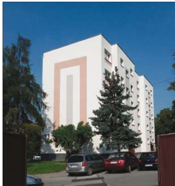
Ocieplony budynek przy ul. Konarskiego 13
