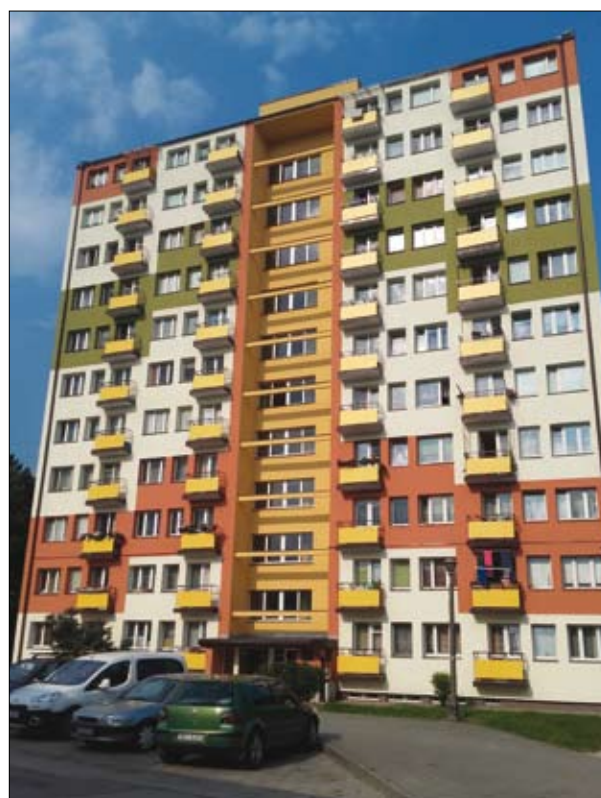
Po dociepleniu, nowa elewacja budynku przy ul. Włoszka 3
