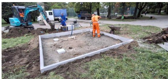
Trwają prace przy tężni ZODIAK
