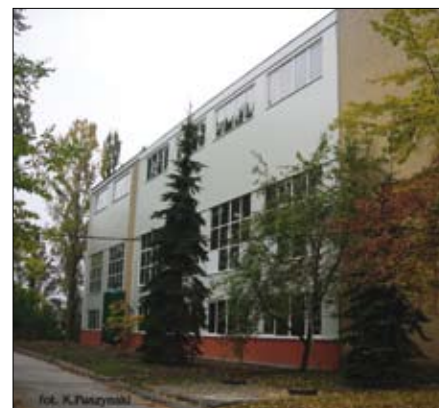
Kotłownia przy ul. Żniwnej
