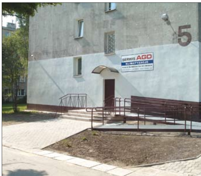
Podjazd przy budynku na ul. Spółdzielczej 5, u góry kamera...
