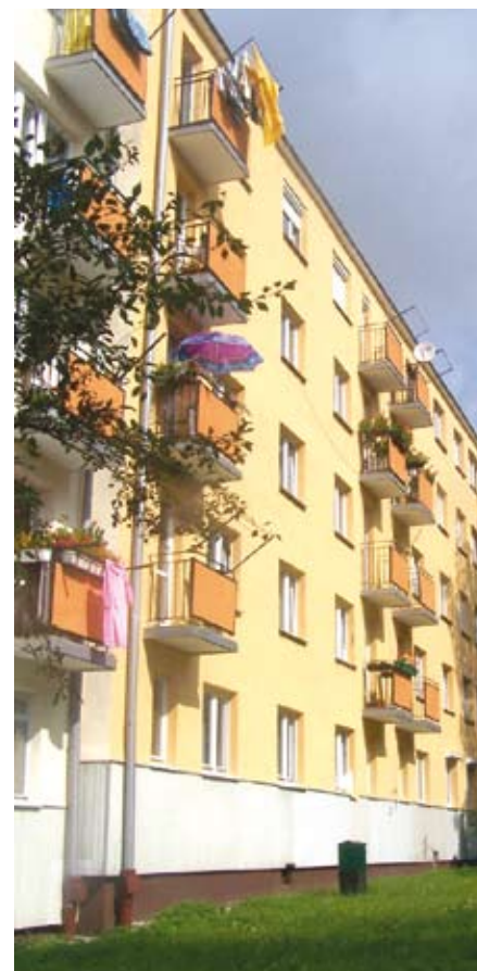
Nowa elewacja w budynku przy ul. Wiosennej 2
