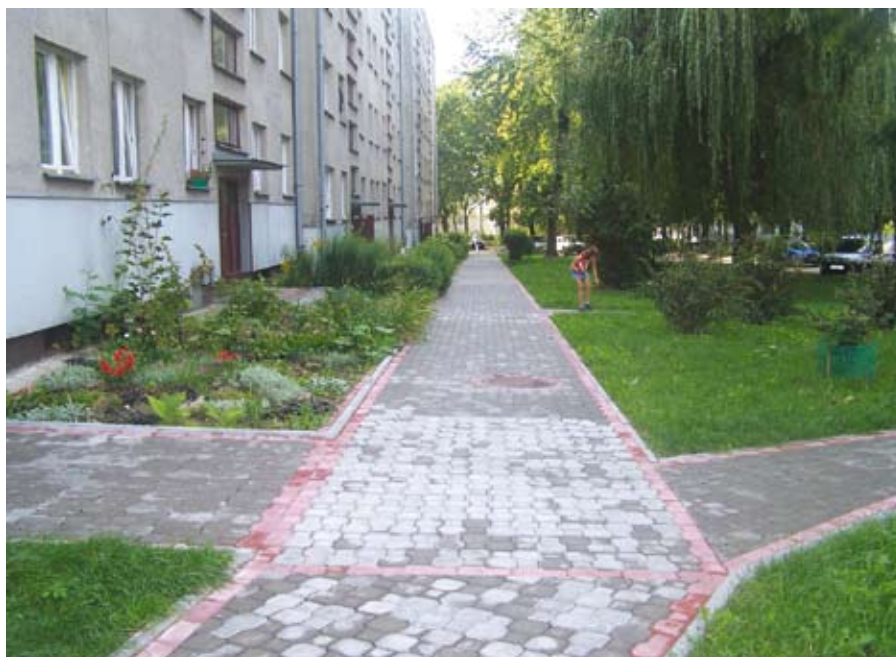
Chodniki po remoncie przy ul. Wiosennej 10 na Sadach
