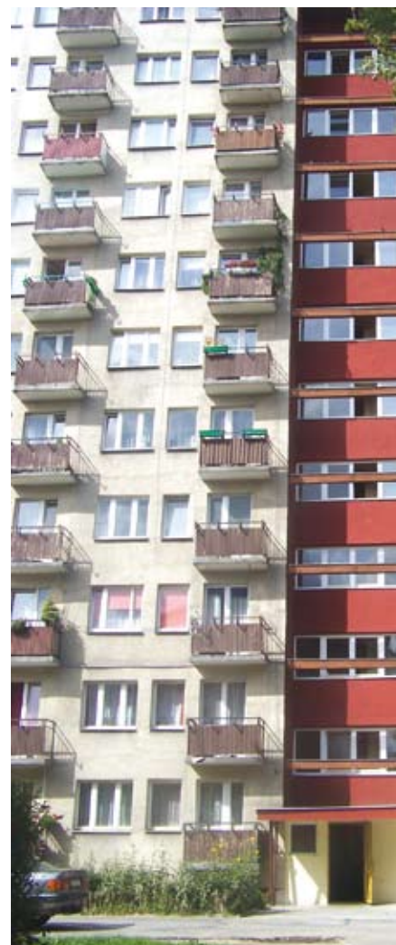
W tym roku na remonty dźwigów przeznaczono 580 tys. zł
