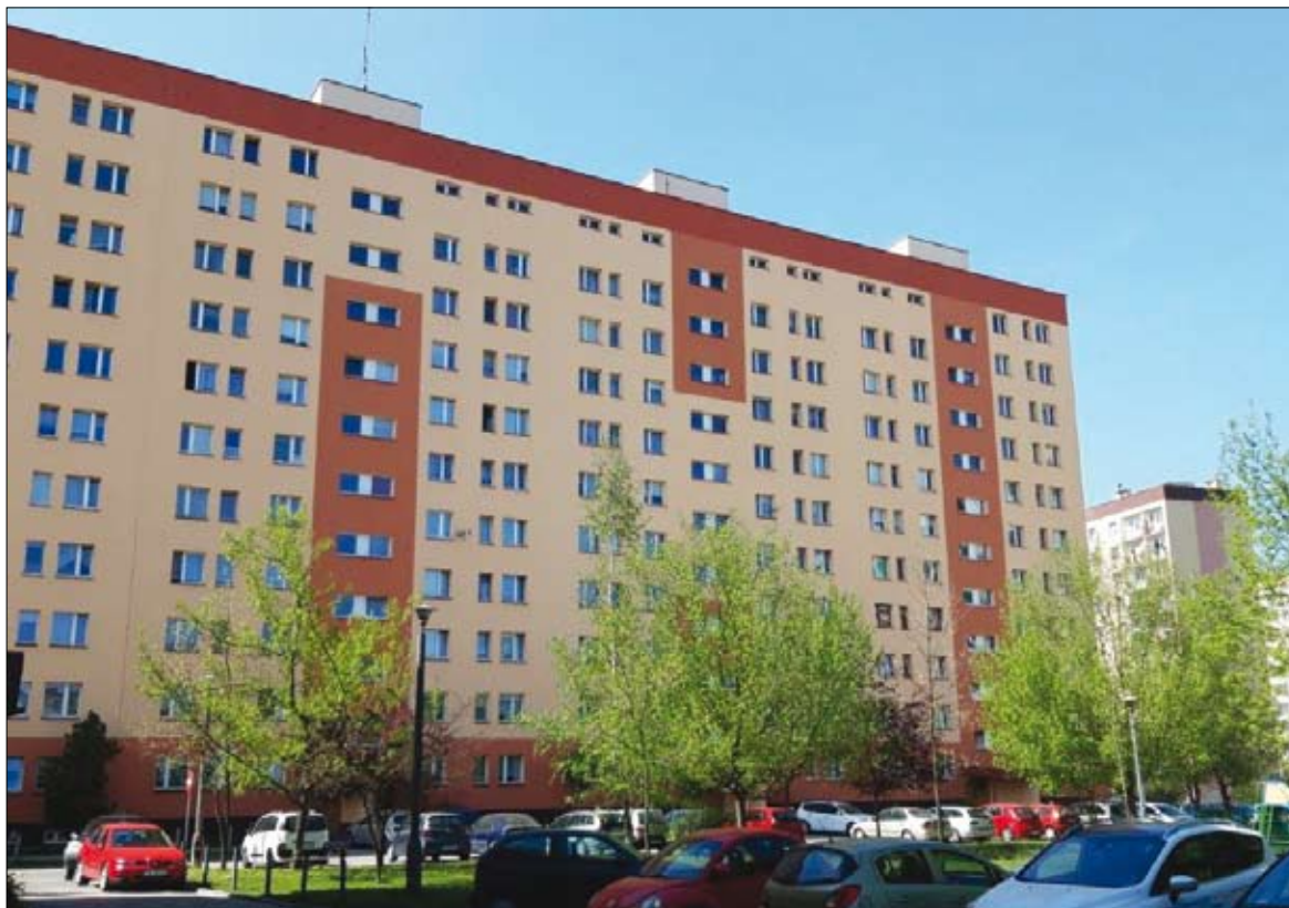
Nowa elewacja budynku przy ul. Romualda 2
