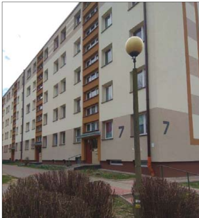
Elewacja po remoncie ul. Boh. Warszawy 7
