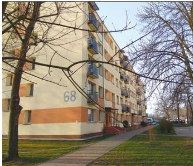
Elewacja po remoncie ul. Zagórska 68
