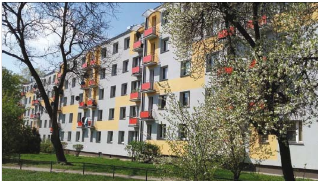
Nowa elewacja przy ul. Pociuszka 5
