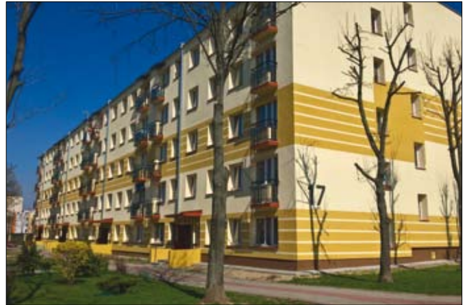
Nowa elewacja budynku przy ul. Boh. Warszawy 17
