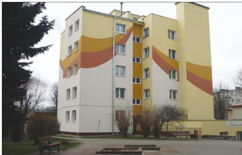
Nowa elewacja, po remoncie budynku przy ul. Karłowicza 2
