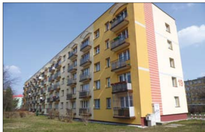
Nowa elewacja, po remoncie budynku przy ul. Kujawskiej 19
