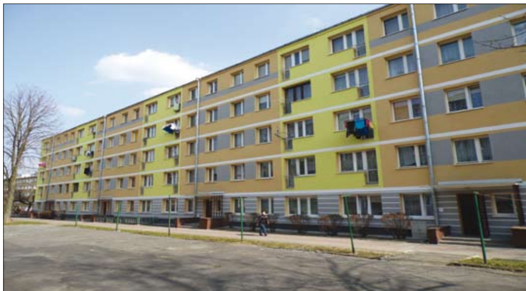
Nowa elewacja, po remoncie budynku przy ul. Spółdzielczej 5
