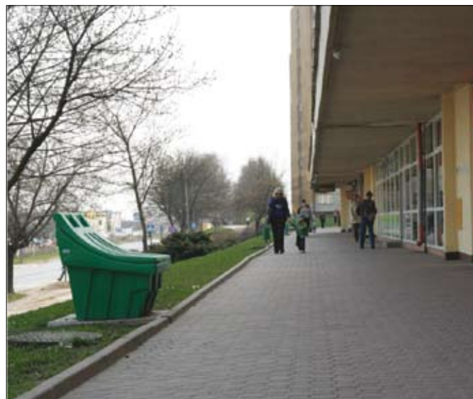
Wymieniona ślusarka okienna w lokalach handlowych Sandomierska 154
