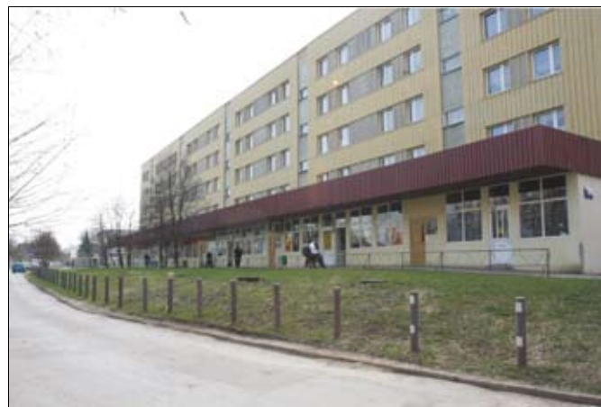
Śłupki chroniące trawiastą skarpetę przy ul. Dalekiej 19
