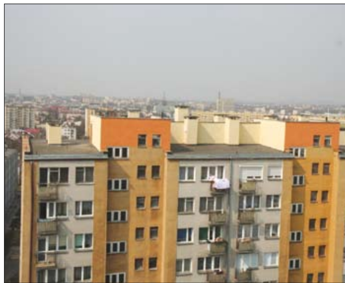
Wyremontowany dach w budynku przy ul. Sandomierskiej 156
