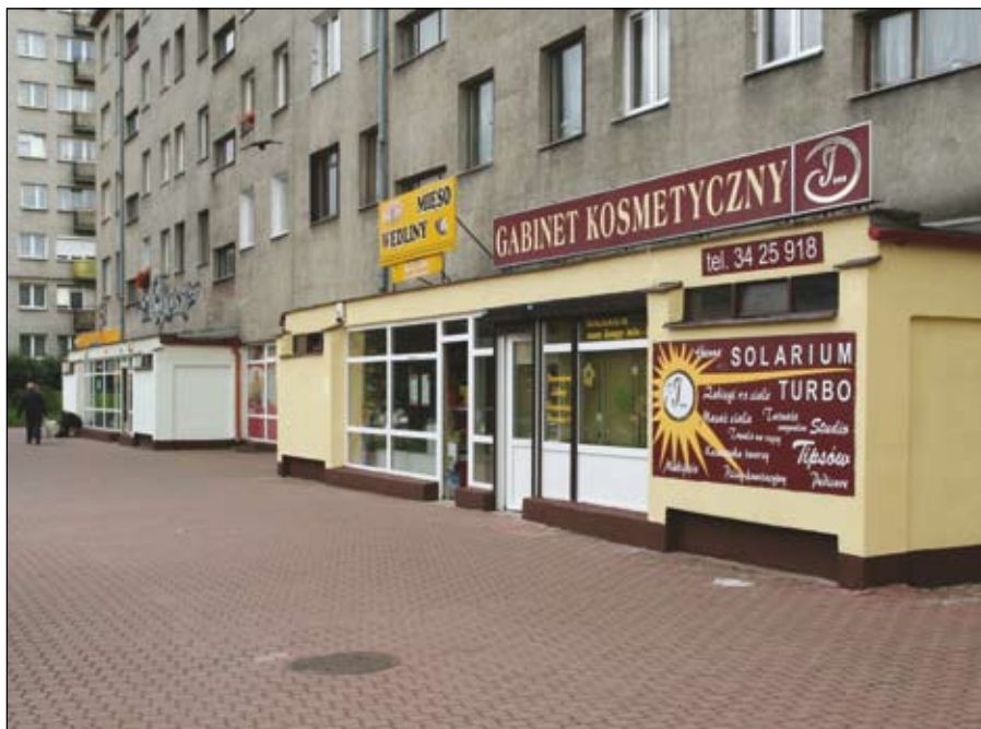
ul. Sandomierska 154 – segment lokali handlowo-usługowych po wymianie okien. Elewacja została odnowiona przez konserwatorów administracji.
