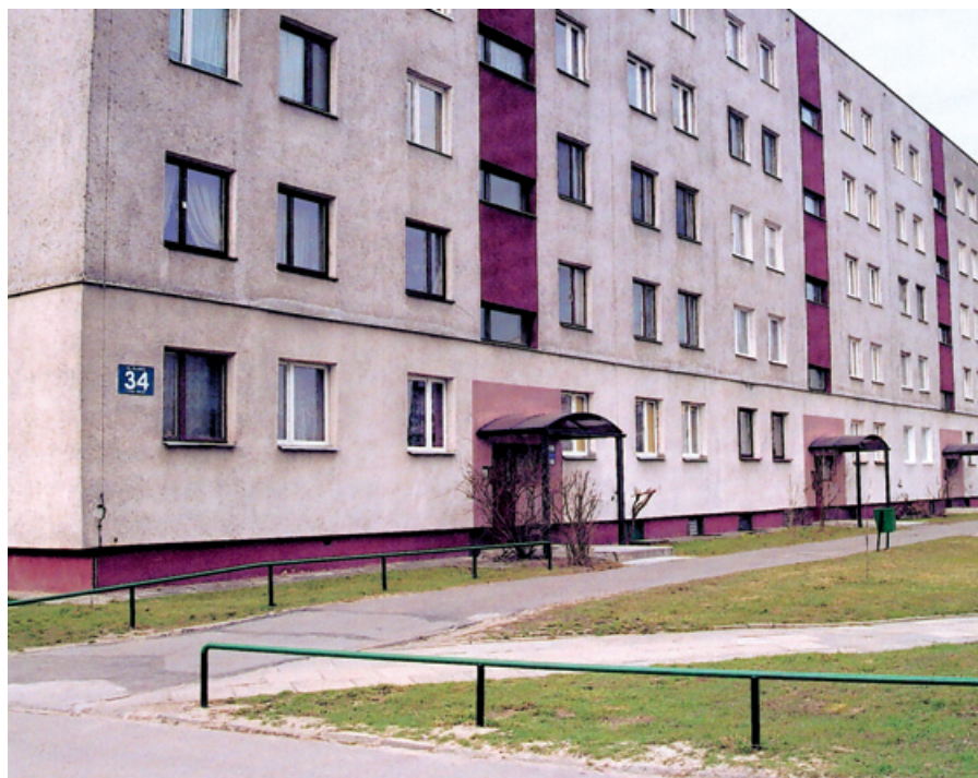
Przebudowane wejścia do klatek schodowych i zadaszenia na ul. Śląskiej 34
