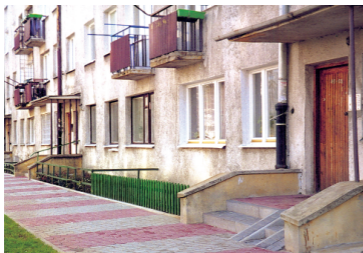
Chodnik z kostki przy ul. Zagórskiej 72
