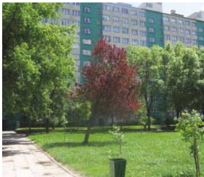
Budynek przy ul. Nowowiejskiej 22
