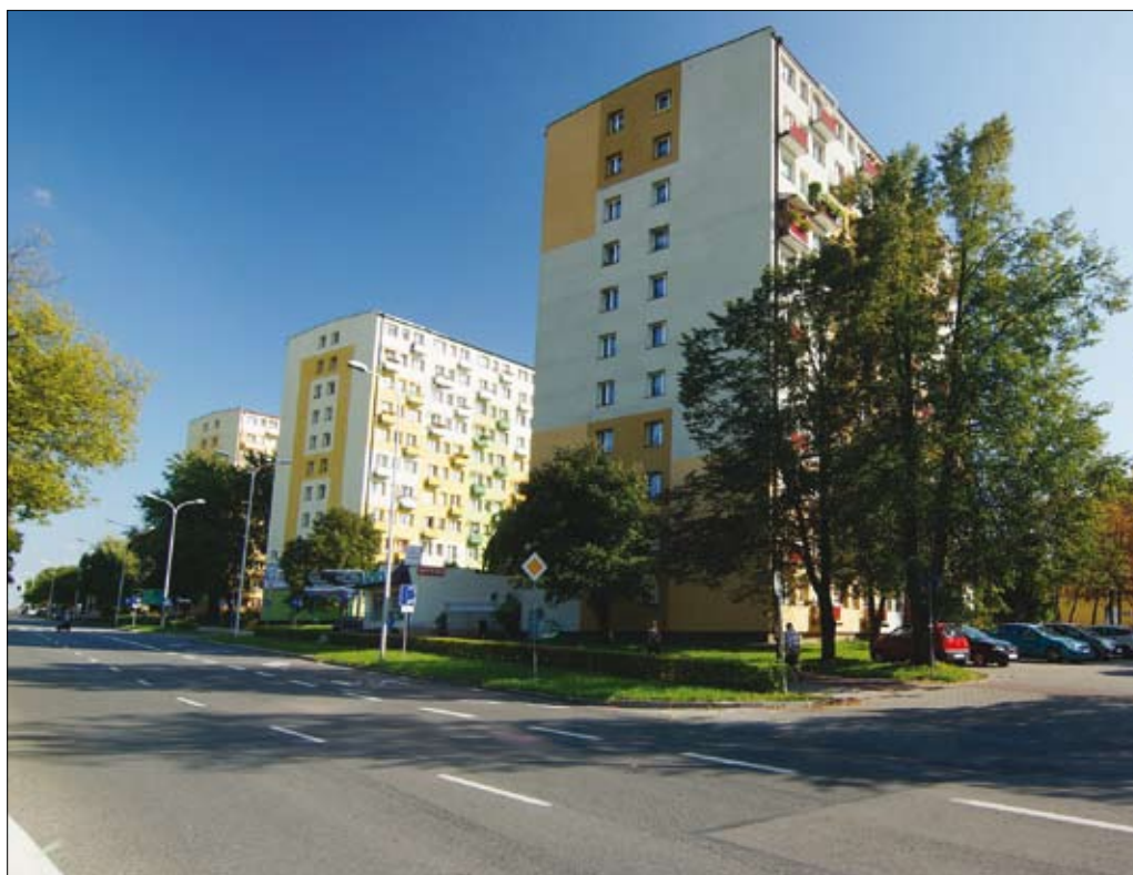
Nowe elewacje wieżowców przy ul. Sandomierskiej
