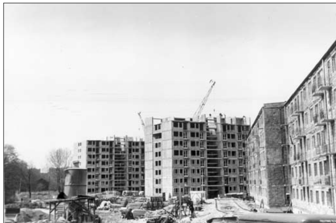
Budowa bloków przy ul. Chopina 15 i 17 Fot. archiwum KSM
