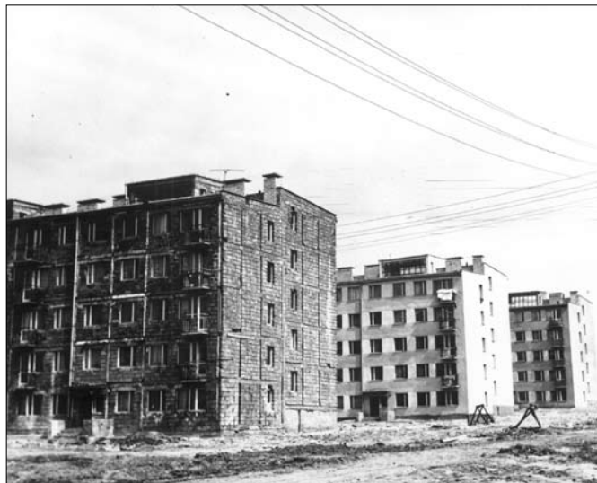
Lata.70. Budowa bloków przy ul. Zagórskiej 66, 68, 70. Zdjęcie z archiwum KSM
