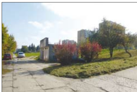
Ul. Sandomierska. Stacja transformatorowa przygotowana pod budowę parkingu na jej dachu. Obok niej miały stać garaże
