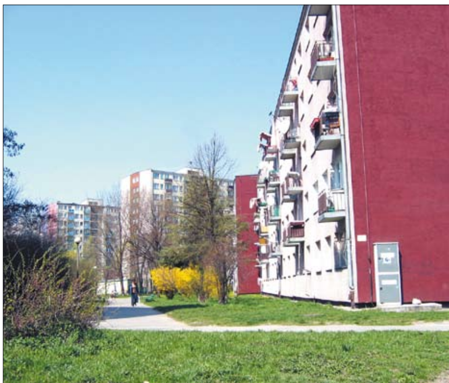
Bloki przy ul. Zagórskiej, budowane w latach 60. i 70. są teraz remontowane. Wymieniane są okna, drzwi wejściowe do klatek schodowych, wokół budynków są nowe alejki i chodniki.
